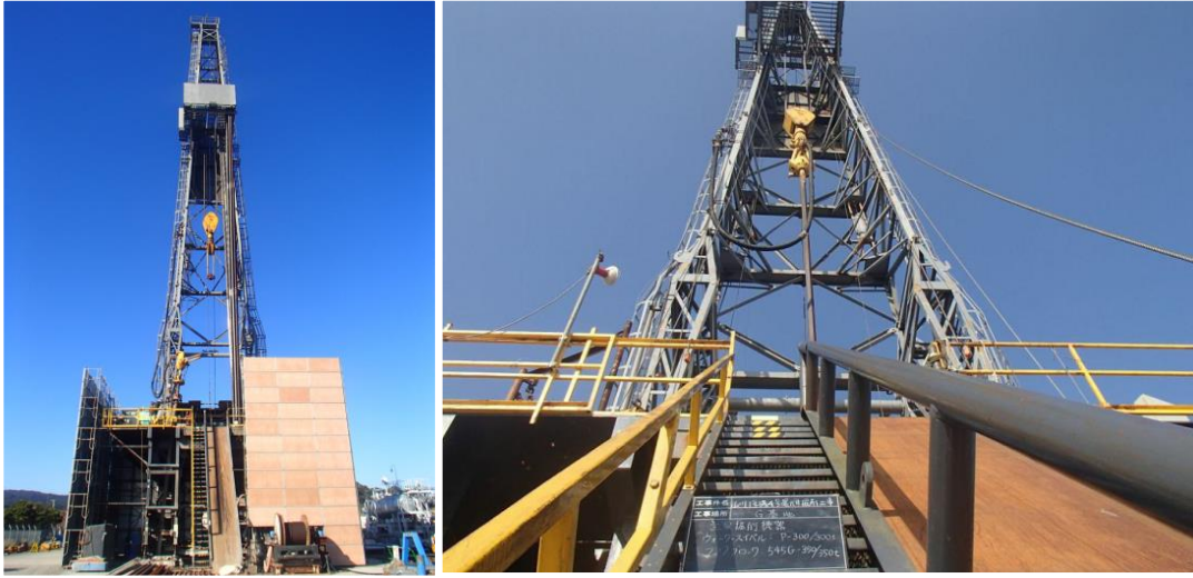
九州電力 山川地熱発電所
