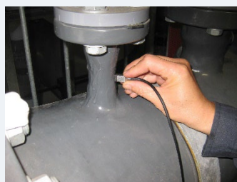
PVC配管の超音波検査
