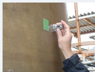
FRPタンクの超音波検査
