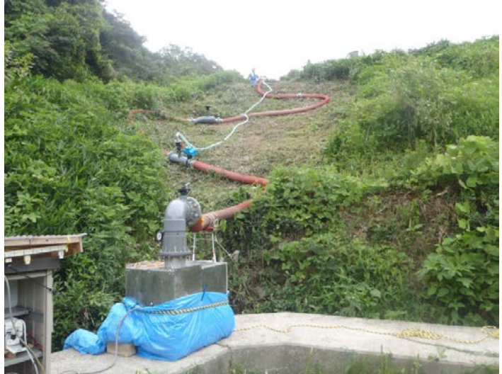
写真2 サイホン式取水装置の全容
