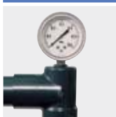
圧力計や温度計などの各種センサーの取り付け。
