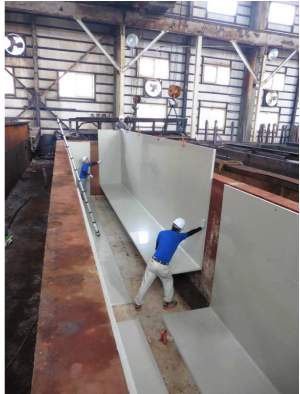
写真 5 既設槽の内面更生作業 (L:15200mm×W:2200mm×H:2200mm)
