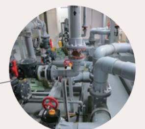
魚や水生生物が嫌う金属イオンを漏れせず、海水で腐食しない樹脂製バルブとパイプ・継手は、水族館にとってなくてはならないアイテムです。
