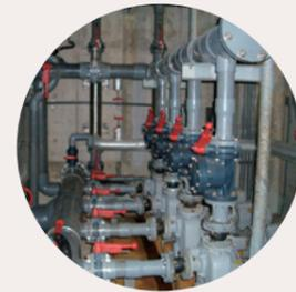
酸で鉄を洗うラインなどでは、薬液の流路だけでなく、外部表面を含めた高い耐食性と動作信頼性が求められます。
