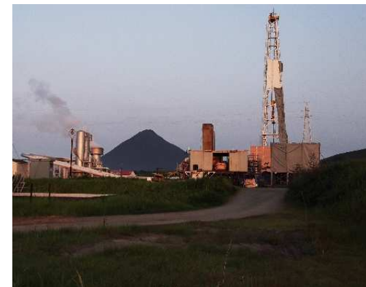
地熱発電掘削現場
