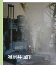
地熱発電用蒸気井
