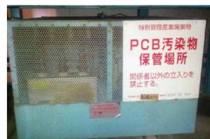
栃木工場での保管状態
