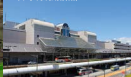
羽田空港第 1 旅客ターミナル (中水再利用設備)
